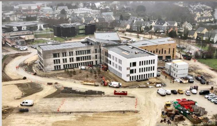
L'immeuble, conçu en R+2, dispose d'un parking en sous-sol dédié au personnel. **Le projet répond également aux exigences E+C- et vise le niveau E2C1.**
