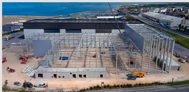
L'usine est composée d'un atelier de 25 m de haut sur une partie et de 15 m sur l'autre, d'une zone de bureaux de 350 m<sup>2</sup> partiellement dans l'atelier, et d'une coursive suspendue surplombant l'ensemble du process.
