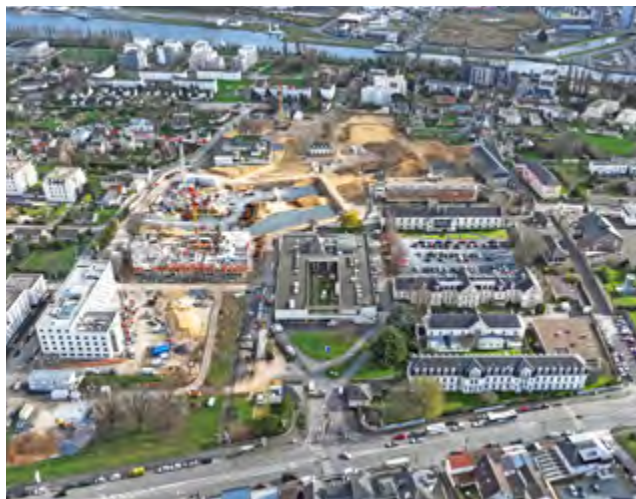
Reconversion de l'ancien site du CHR Clémenceau Les Coteaux de l'Abbaye - Caen (14)
